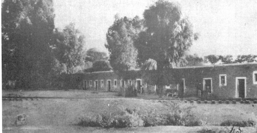
15. Cada familia recibía un cuarto y una cocina en grandes construcciones de adobe que generalmente alojaban a veinticinco familias.
